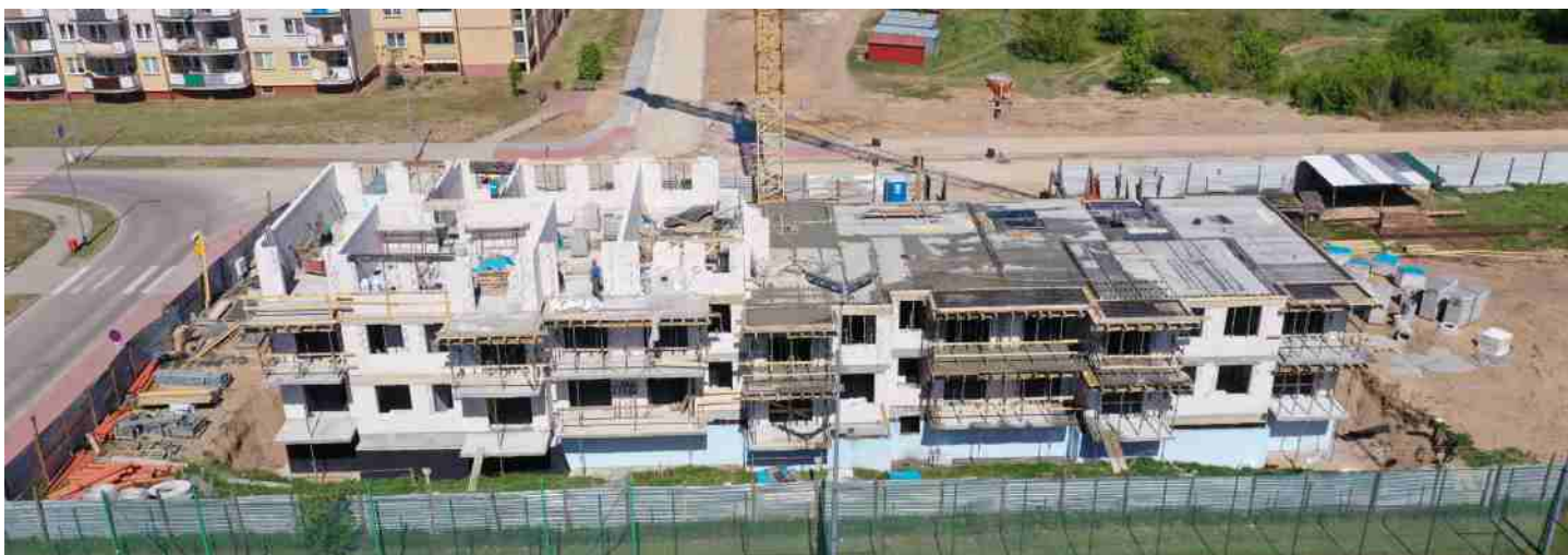
Budowa budynku wielorodzinnego trzyklatkowego na os. Południe w Grajewie
