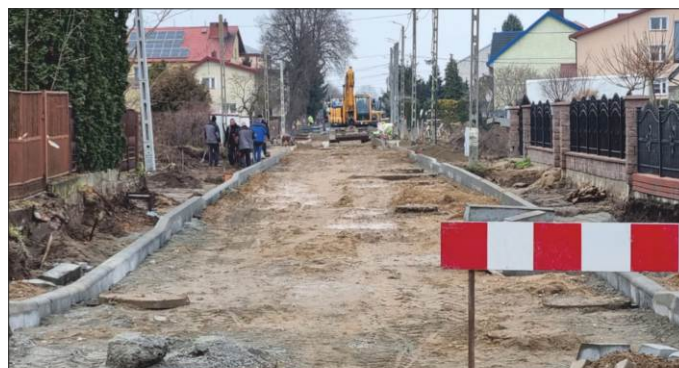
Realizacja inwestycji „Budowa ciągu ulic: Łąkowej, Stefczyka, Działkowej, Kwiatowej i Kolejowej na os. M. Konopnickiej w Grajewie”
