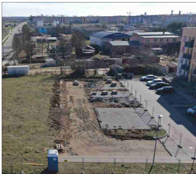
Budowa budynku mieszkalnego wielorodzinnego przy ul. Targowej w Grajewie
