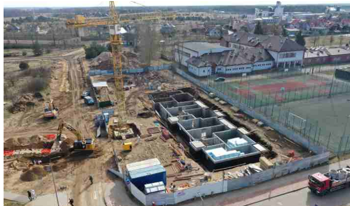
Blok z czynszowymi mieszkaniami na wynajem jest budowany na osiedlu Południe
